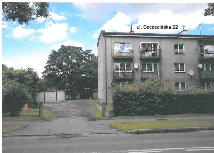
Widok drogi dojazdowej do budynku Szczecińska 22
